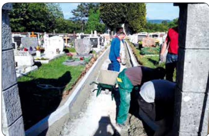
Postavljanje kamnitih robnikov na vaškem pokopališču. Foto: Karel Ravbar
