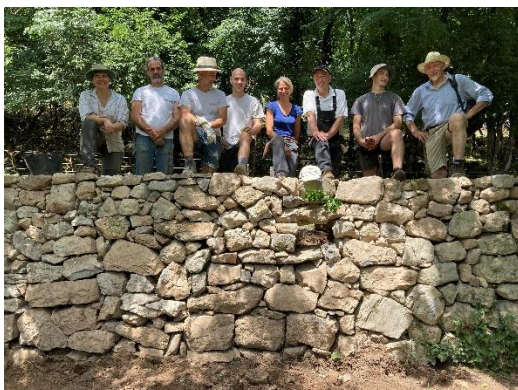
Obnova dveh podpornih zidov v Parku Škocjanske jame v okviru izobraževanja o veščini kraške suhozidne gradnje v letu 2023 in 2024
