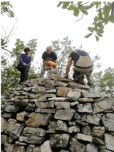
Izobraževanje o veščini v letu 2024: obnovljena pastirska hiška pri Gorjanskem
