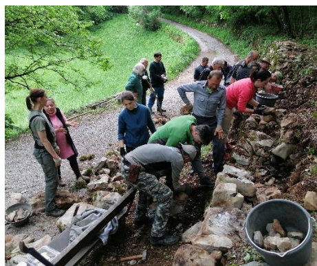
Obnova dveh podpornih zidov v Parku Škocjanske jame v okviru izobraževanja o veščini kraške suhozidne gradnje v letu 2023 in 2024
